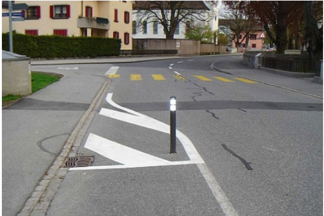
Abbildung 13: Referenzbild - Sperrfläche mit Poller - Massnahme Schwachstelle 88.23 (Juchstrasse) (Quelle: Gemeinde Neerach)
