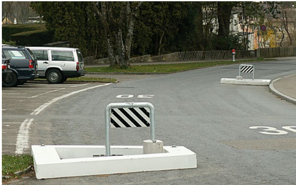
Abbildung 15: Referenzbild - provisorische Elemente zur Strasseneinengung - Massnahme Schwachstelle 88.08, 88.22 (Quelle: Gemeinde Neerach)
